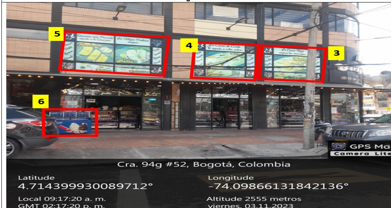
Se evidencian tres (3) elementos de publicidad incorporados a las ventanas de la edificación identificados con los números 3,4 y 5; Así mismo, se evidencia un (1) elemento de publicidad instalado en área que constituye espacio público descrito con el número 6
